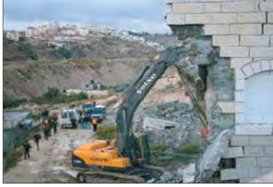
أعمال الهدم لبيوت الفلسطينيين المقدسين في منطقة برج اللقلق
