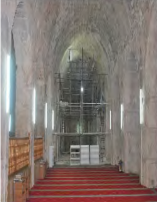
أعمال الترميم داخل المصلى المرواني
